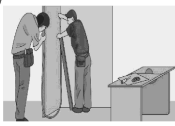
⑧施工時，利用水管測量水平
